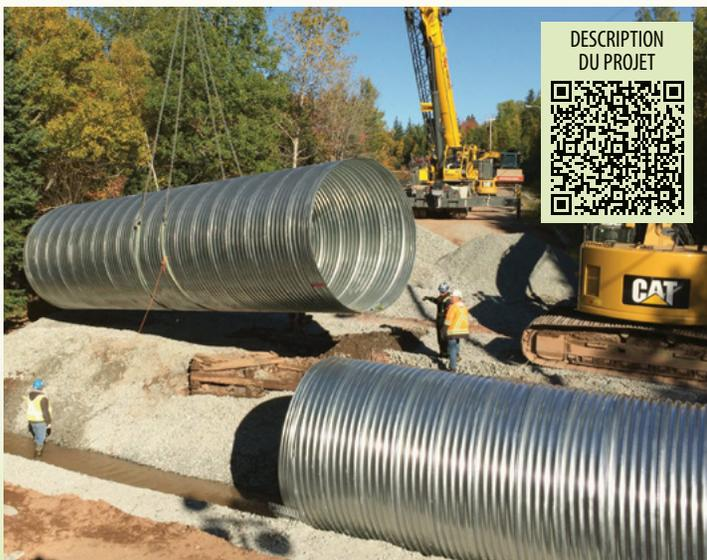
**Solution d'urgence :** ce grand ponceau de remplacement a été fabriqué et livré en 24 heures pour remplacer une structure emportée par les eaux au Cap-Breton.
