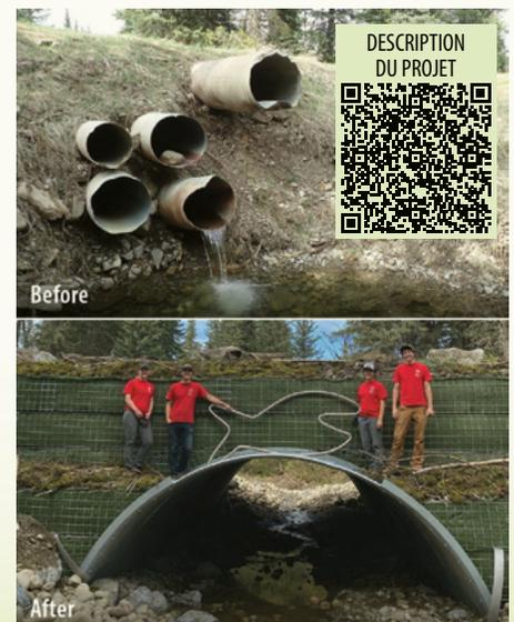
Un pont de terre renforcée par géotextile (GRS) AIL remplace une mauvaise configuration de ponceaux et rétablit le passage des poissons dans un ruisseau de l'Alberta.
