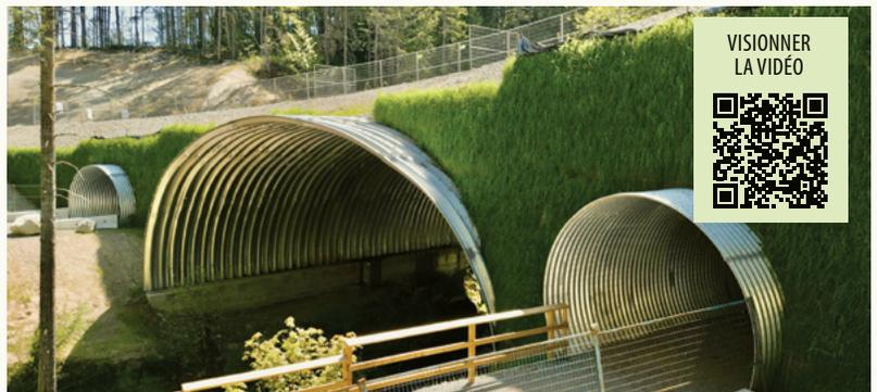
**Des solutions à faibles émissions de carbone :** cette traverse de cours d'eau en tôle forte Ultra-Cor, située près de Nanaimo, en Colombie-Britannique, a un cycle de vie global à plus faible bilan carbone qu'un pont à poutres en béton.
