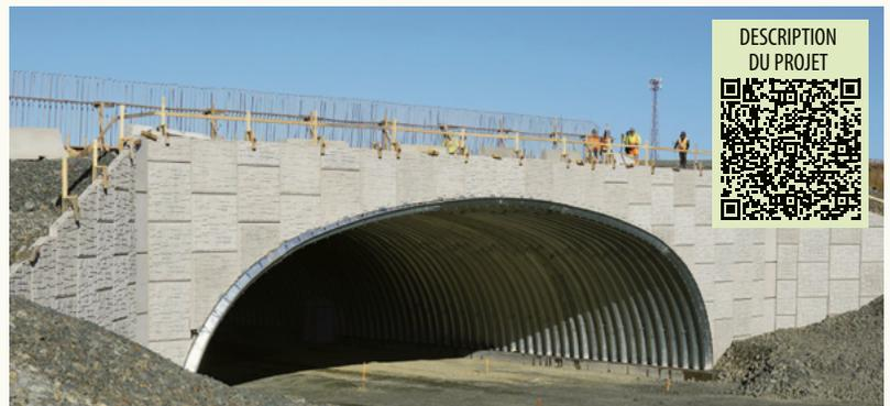
**Des solutions à faibles émissions de carbone** : ce pont d'étagement en tôle forte Ultra-Cor, situé près de St. John's à TNL, a un cycle de vie global à plus faible bilan carbone qu'un pont à poutres en béton.
