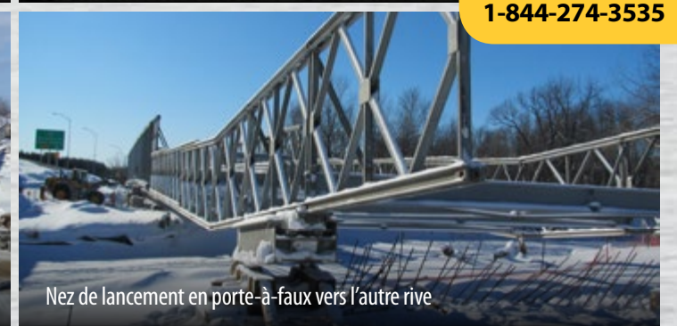
Mise en place à partir d'un côté sans matériel de levage
