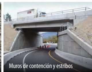
Muros de contención y estribos
