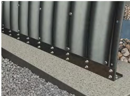
Los segmentos se emperran a canales en la base que son integrados al concreto.
