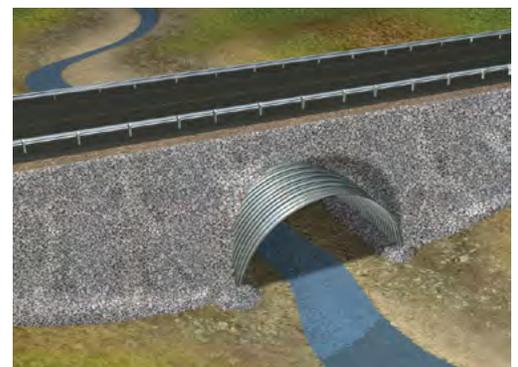
A la superficie de terreno culminada se le agregan barreras de seguridad.
