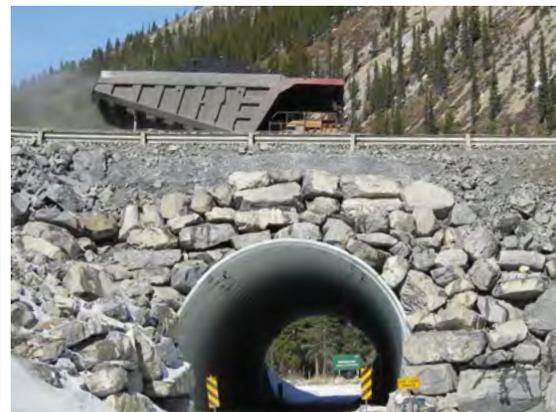
Las estructuras Super-Cor® son fabricadas de conformidad con los requerimientos de diseño de CHBDC, AASHTO y ASTM
