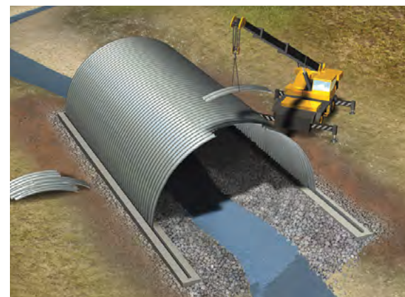
Las placas restantes luego se adhieren individualmente para conformar cada segmento de arco en secuencia.
