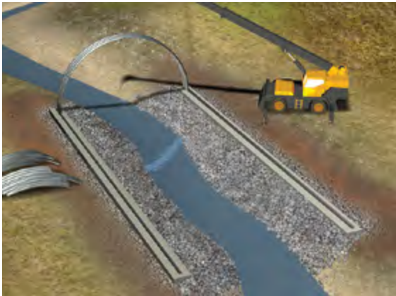
Luego, se levanta y coloca en su lugar y es apertado a los cimientos de ambos lados.
