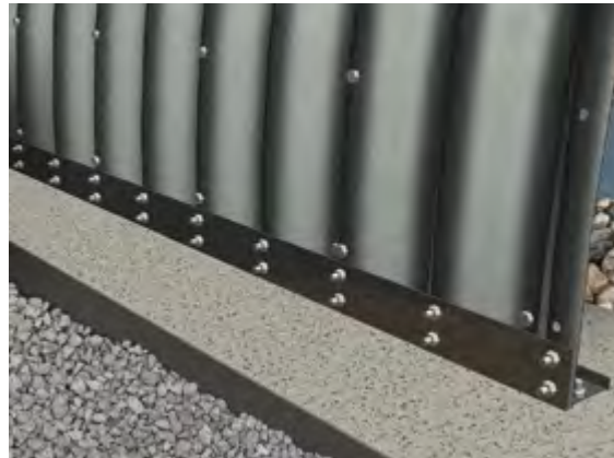
Los segmentos se apertan a una viga metálica integrada en la base a las fundaciones.
