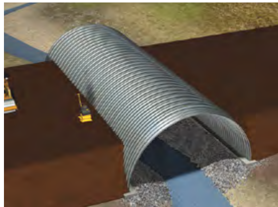
Se agregan las capas de relleno estructural en niveles sucesivos.
