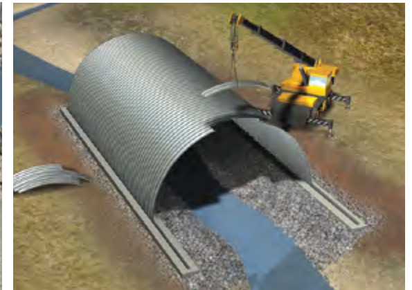
Las placas restantes luego se adhieren individualmente para conformar cada segmento de arco en secuencia.
